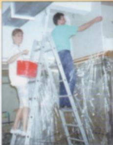
**Ein Wochenende mit 40 fleißigen Helfern + Vollgips-Decke abgerissen + Metallverstreben entfernt + 30 m Luftkanäle ausgebaut + Löcher verschlossen, verspachtelt und verkleidet + 2,5m Bauschutt entsorgt + 70 Liter Farbe verstrichen + 800 m<sup>2</sup> Folie verklebt + OTA-Lehrlinge verlegen Elektrik + Garderobe mit Waschbecken im Entstehen + Große Vitrinen warten auf Auftrittsfotos +**
